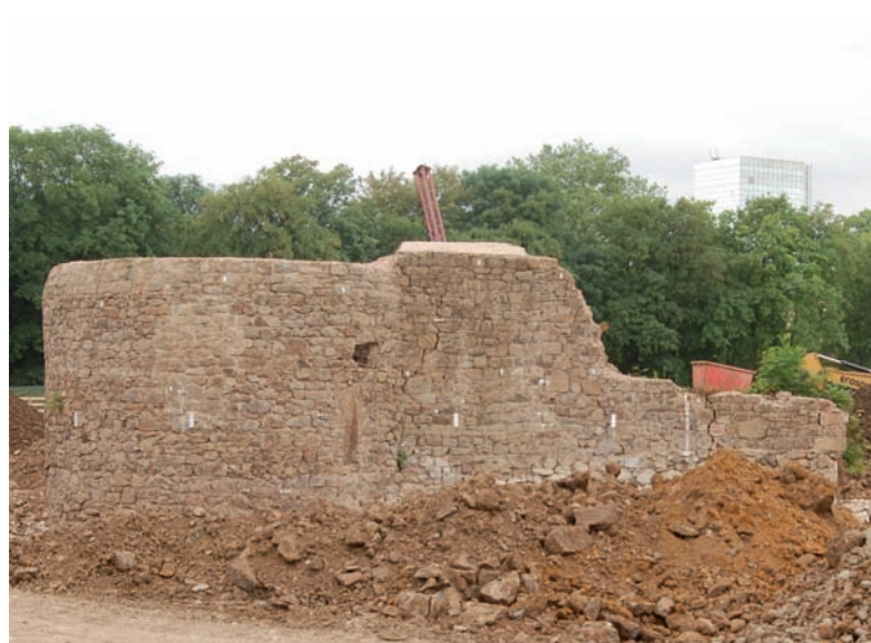
Eiskeller. Ansicht des Bauwerks: 1 von Süden (Mai 2008); 2 von Westen (Mai 2008); 3 von Nordosten (Mai 2009). Die Aufnahmen 1 und 2 zeigen das Bauwerk mit der verputzten Außenkuppel, 3 dokumentiert den Zustand nach Abbruch der Innen- und Außenkuppel.
