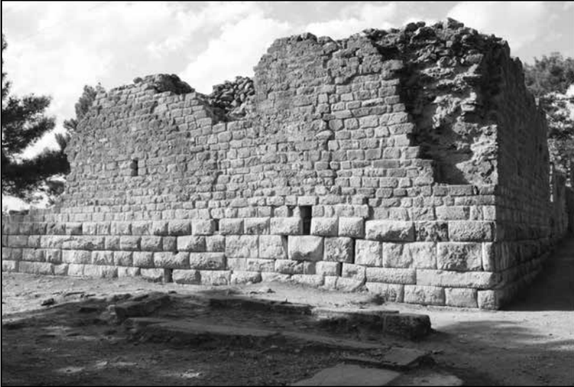
Resim 9: Roma Hamamı doğu dış duvarının restorasyondan sonraki durumu (A. Hoffschildt).
