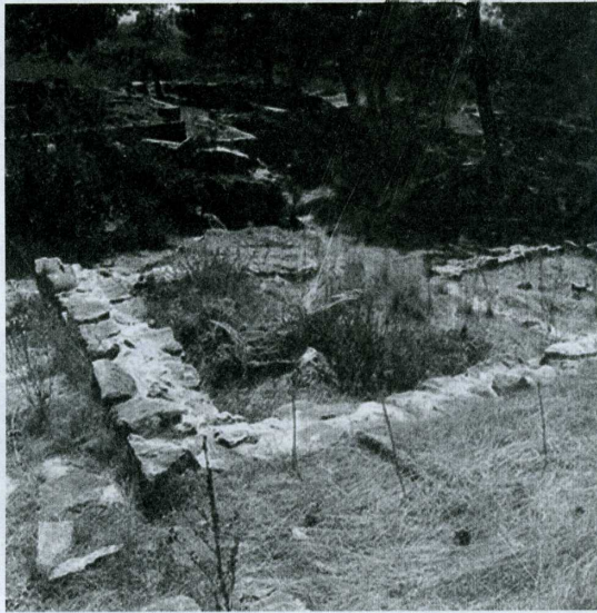
Abb. 6: Sicherungsarbeiten an den Mauerkronen von Wohnhäusern (W. Raeck)
