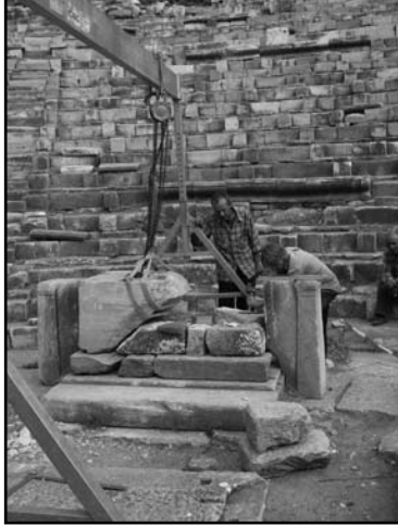
Resim 3: Sicherungsarbeiten am Theateraltar. Tiyatrodaki sağlamlaştırma çalışmaları
