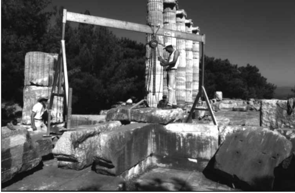
Abb. 1 Restaurierungsarbeiten an der Cellamauer des Athenatempels Resim 1: Athena Tapınağı'nın cella duvarında yürütülen onarım çalışmaları
